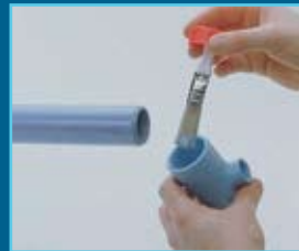
Lijm aanbrengen op zowel buis als fitting
